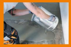
Die direkt nutzbare mineralische Beschichtung wird ausgegossen und lässt sich ohne Kraftaufwand verteilen.
