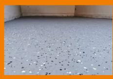
Mit Farbchips optisch aufgewertet und mit PCI Zemtec Protect geschützt schafft PCI Zemtec Outdoor einen direkt nutzbaren Boden im freibewitterten Außen- oder nassbelasteten Innenbereich.
