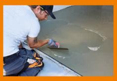
Trotz flüssiger Konsistenz lässt sich PCI Zemtec Outdoor ganz einfach und ohne Nachsacken an Abflüsse und Kanten anarbeiten, selbst auf Gefälle.
