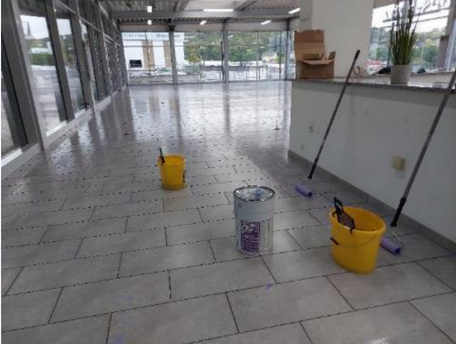
Den Altbelag grundierten die Handwerker mit PCI Gisogrund 404. ( Link zum hochauflösenden Photo)
