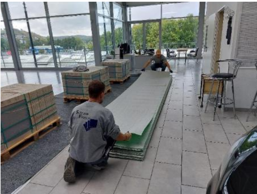
Entsprechend der PCI-Aufbauempfehlung kam PCI Pecilastic E zur Entkopplung zum Einsatz. ( Link zum hochauflösenden Photo)
