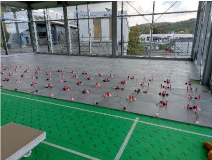
Auch für die Verklebung der Fliesen verwendeten die Handwerker PCI Flexmörtel S1 Flott, für das Verfugen den zementären Mörtel PCI FT Megafug. ( Link zum hochauflösenden Photo )
