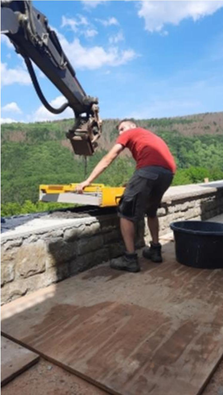
*Insgesamt wurden 53 Meter Mauerabdeckungen aus robustem Grauwacke-Naturstein verlegt. Jede einzelne dieser Abdeckungen ist eine Sonderanfertigung und wiegt 60 Kilogramm.
