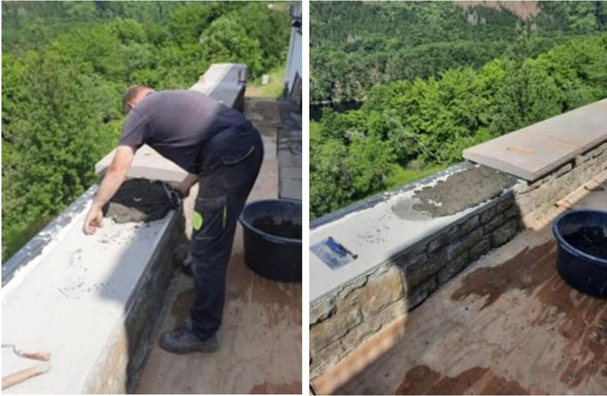
Die Verlegung der massiven Grauwacke-Mauerabdeckungen erfolgte in mehreren Schritten. Auf den vorbereiteten Untergrund trugen die Handwerker eine Kontaktschicht aus PCI Carrament grau auf und überzogen sie mit PCI Carraroc in der gewünschten Schichtdicke von maximal 40 mm.
