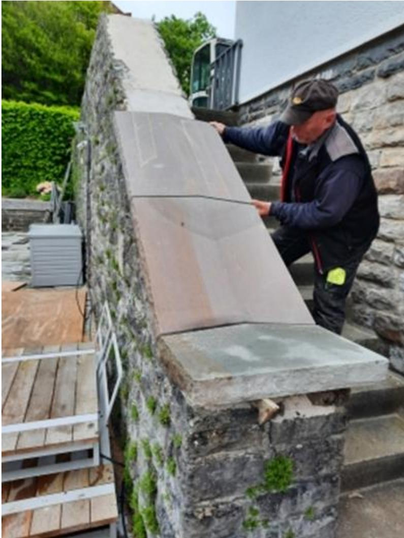
Anschließend wurden die Abdeckungen in das noch feuchte Mörtelbett eingelassen und mit Edelstahlstiften und -winkeln zusätzlich am Untergrund verankert. ([Link](#) zum hochauflösenden Photo)
